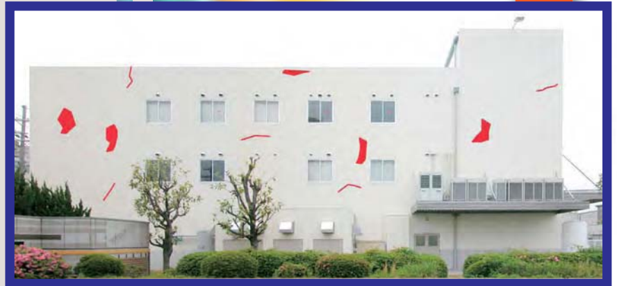
赤外線画像と可視画像の合成(劣化箇所の検出)
